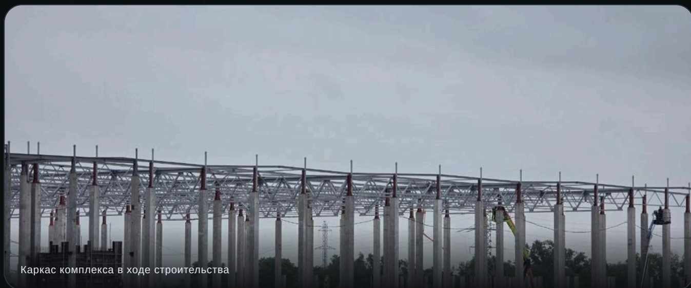
Монтаж конструкций покрытия
